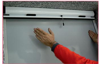
**3** Placer les clips de fermeture cachés ou réglables dans la partie inférieure des coulisses
